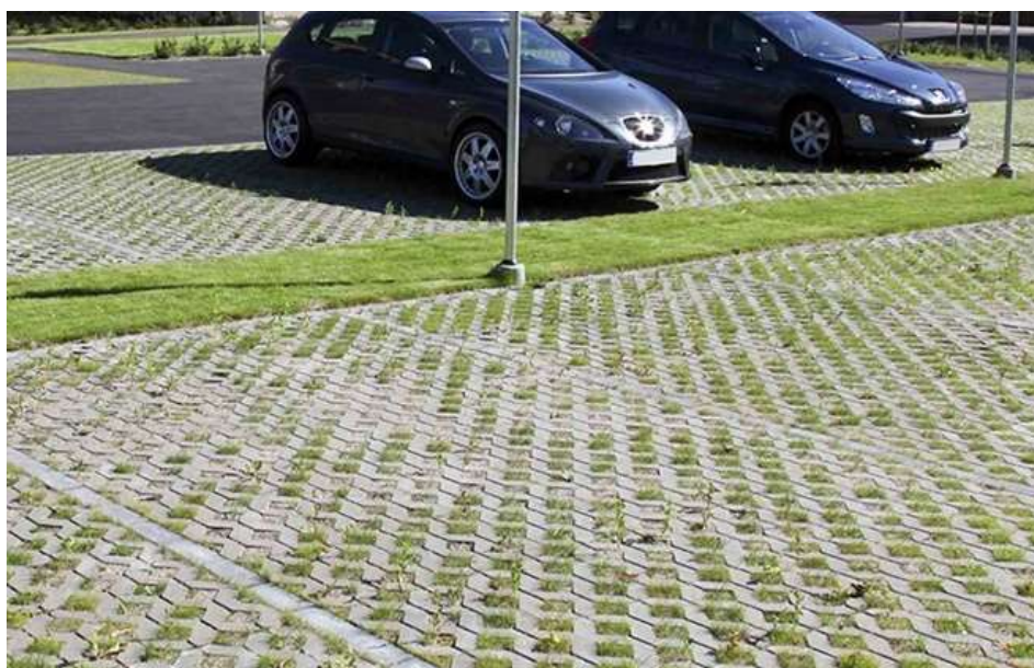
Bild 7: Gräsarmering i betong skapar en infiltrerbar yta.
