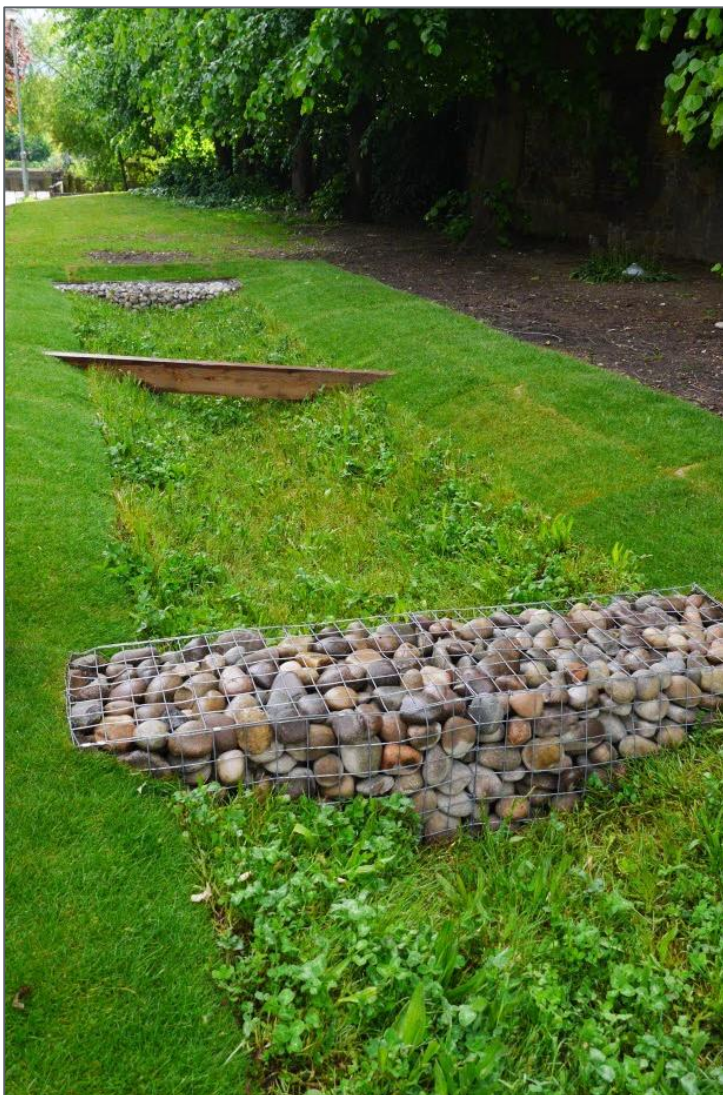
Figur 11. Gräsbeklätt dike med flödeshinder. (Boverket, 2019)
