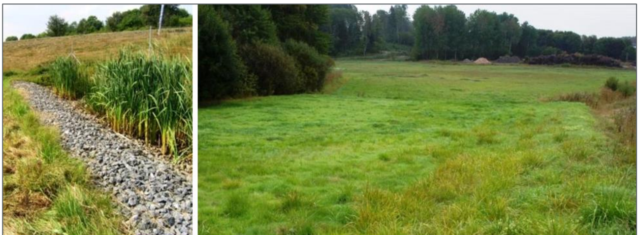
Figur 10. Inloppsdike och översilningsyta i Norrtälje (VA-guiden, n.d.)
