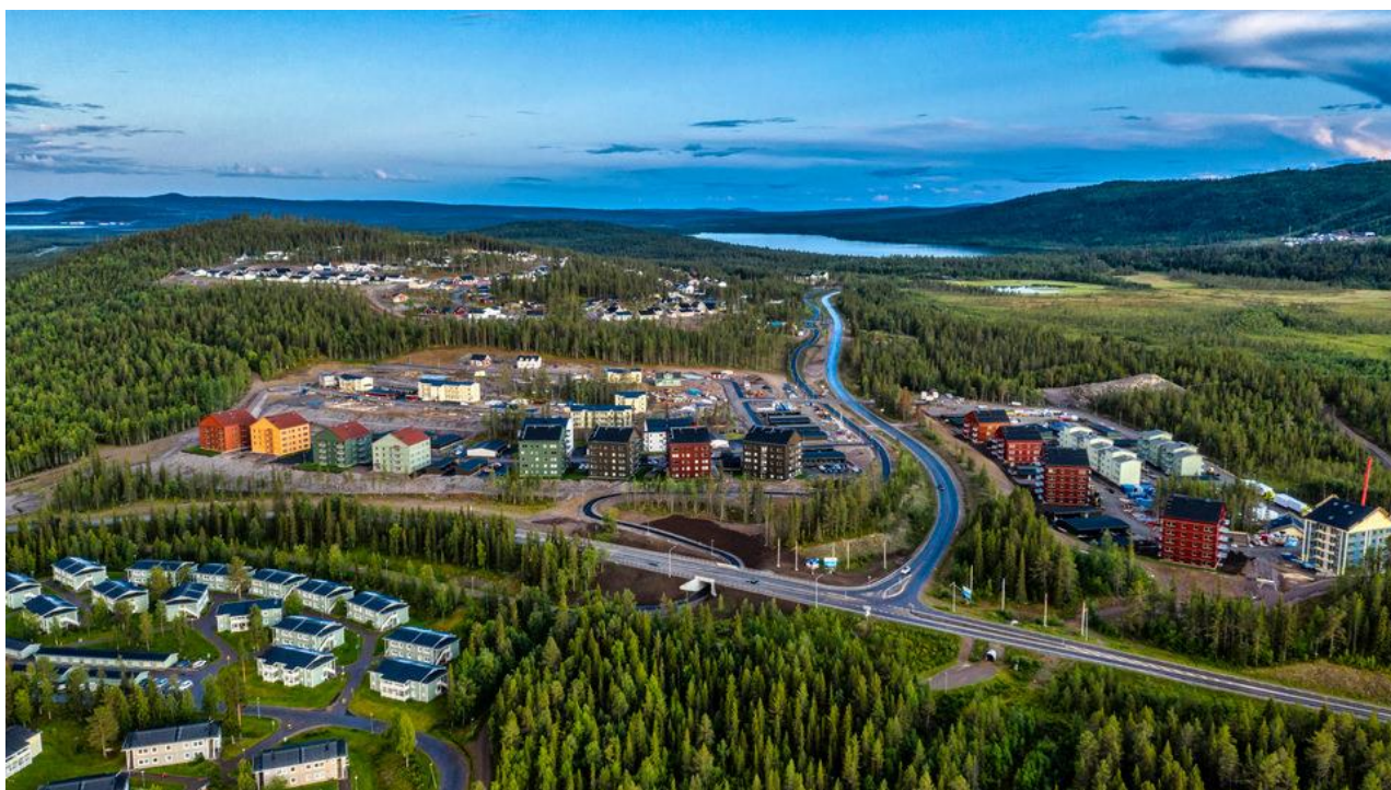
Figur 13 Repisvaara norra under uppbyggnad.
