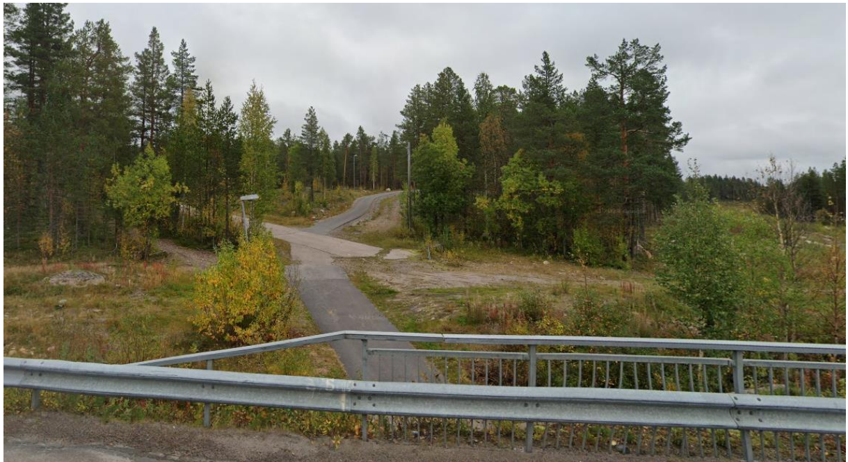
Bild 7: Vy från Malmbergsleden väster om planområdet som visar befintlig gång- och cykelväg inom planområdet. Foto taget mot nordöst. Urklipp från Google Streetview (bildinsamling september 2024).
