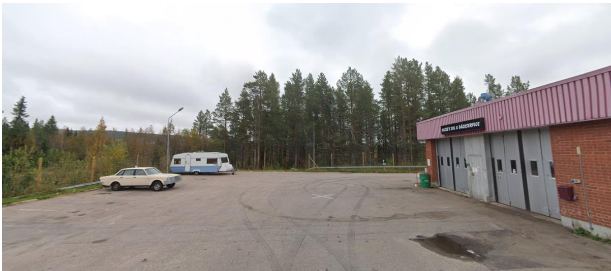
Bild 9: Stora delar av planområdet utgörs av hårdgjord mark. Foto taget mot öster. Urklipp från Google Streetview (bildinsamling september 2024).
