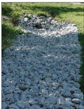
Figur 7-1 Flödesspridare av stenar fördelar det koncentrerade flödet och avleder flödesenergin (Rocco, 2010).
