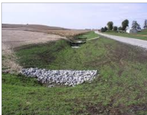
Figur 7-3 Flödeshinder i dike består av en vertikal barrier som kan bestå av sten. Flödeshinder begränsar flödes hastigheten hos väldigt koncentrerad avrinning och kan förhindra erosion och kan också ge in viss sedimentavskiljning. Brantare bottenlutningar kräver kortare avstånd mellan hindrena (efter: (North Carolina Sedimentation Control Commision, 2013; Institute of Transportation Iowa State University, 2022).
