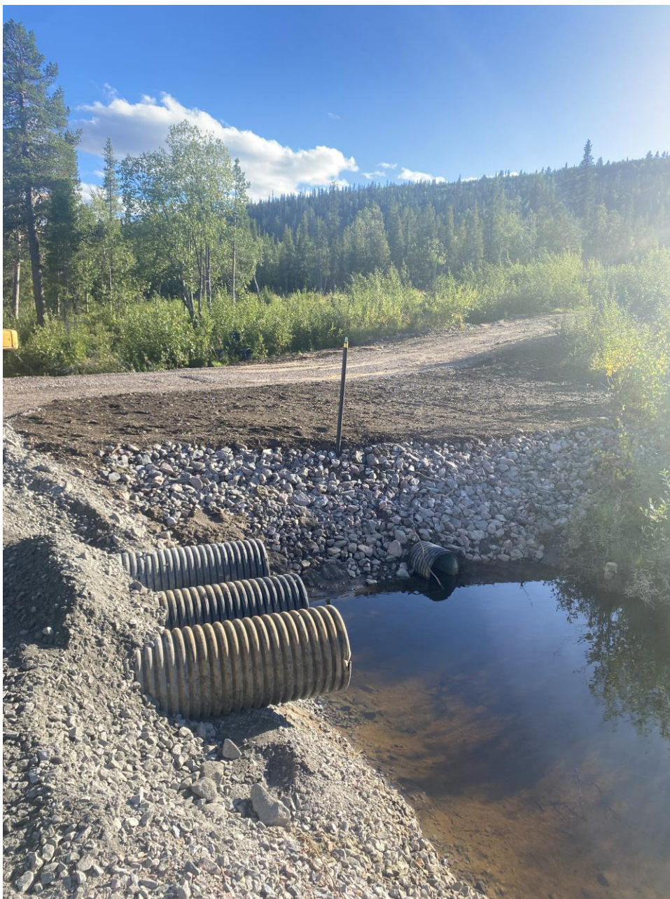
Figur 5. Nyanlagt dike som leder vatten mot sedimentationsdammar. IMG_7170.jpg.
