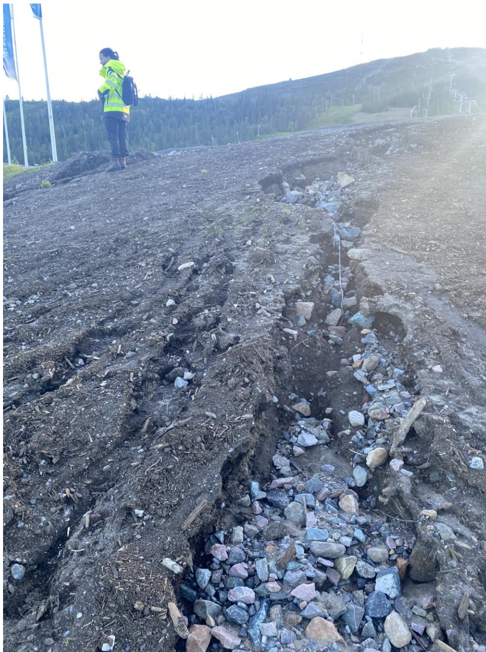
Figur 7. Erosionsfårer i utlagd matjord. IMG_7192.
