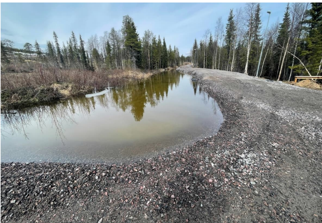
Figur 14. Vattenstånd i dike 5 (2022-05-24) efter en tid av snöavsmältning. Från vattenspegeln upp till körbanan finns ca 0,4 meters marginal.
