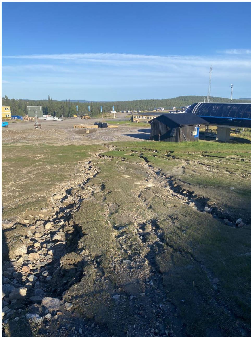
Figur 40. Erosionsfårar. IMG_7458.jpg.
