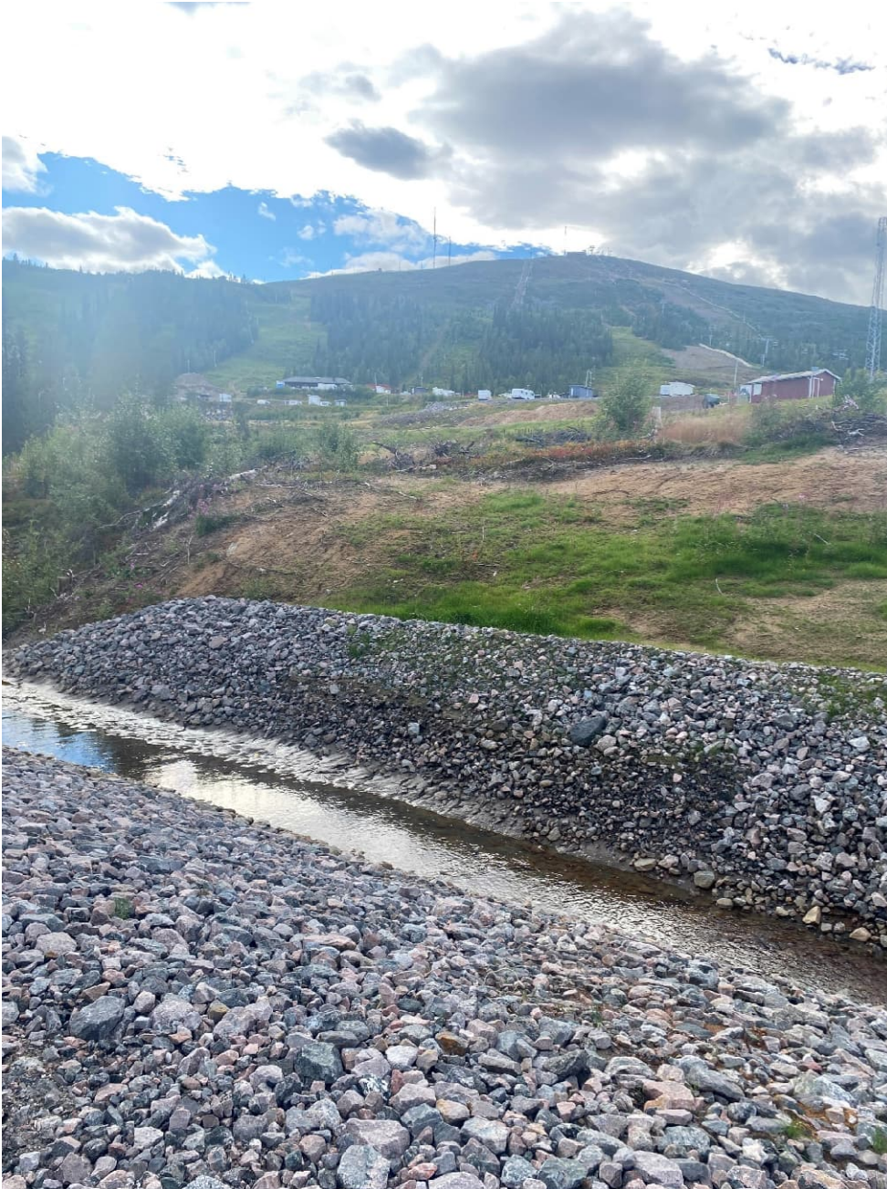
Figur 15. Vattenstånd i dike 5 2022-08-23 efter några förhållandevis regniga veckor.
