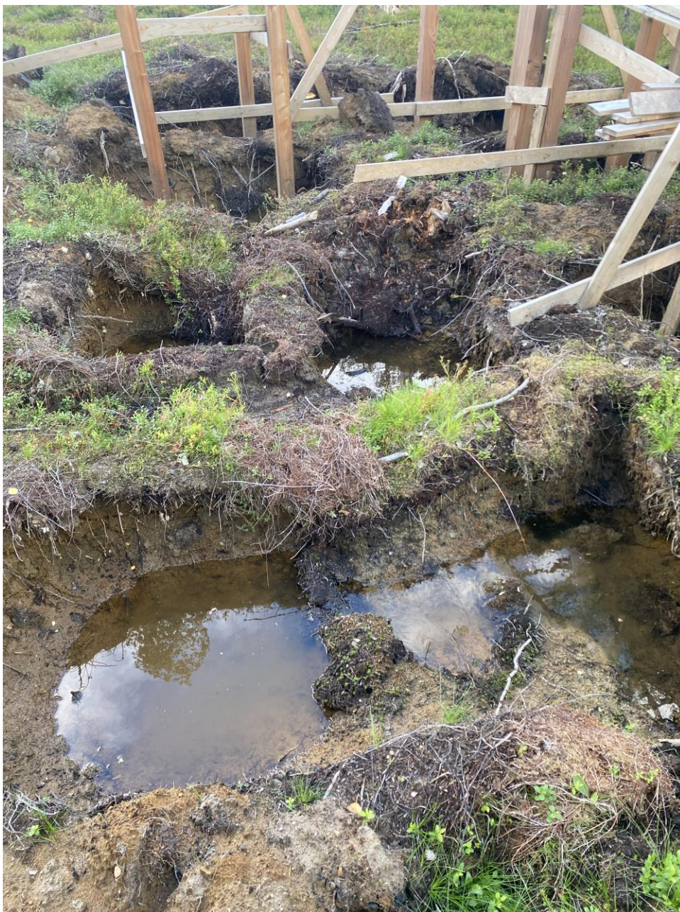
Figur 4. "Provgropar" i anslutning till byggarbetsplats för nytt utegym eller liknande. Vattenyta ca 0,3 meter under omgivande mark. IMG_7132.
