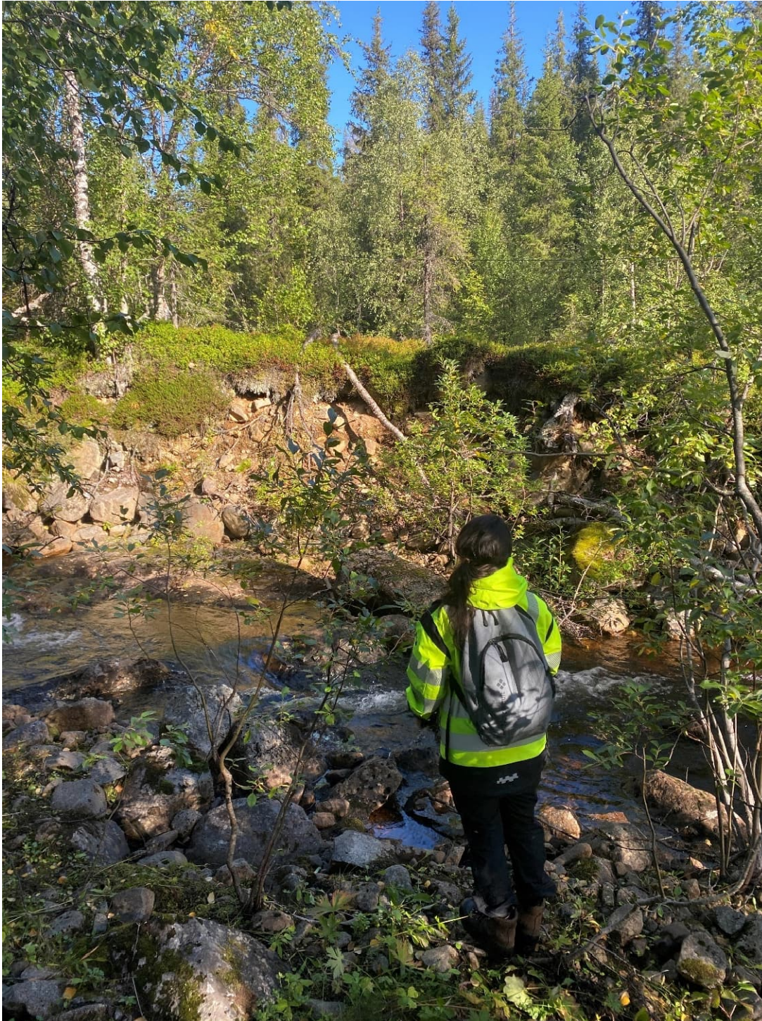
Figur 22. Mindre jordskred alternativt ras på bortre sidan av bäcken, lokaliserat under fältarbetet. IMG_7292.jpg. Se läge i bilaga C.
