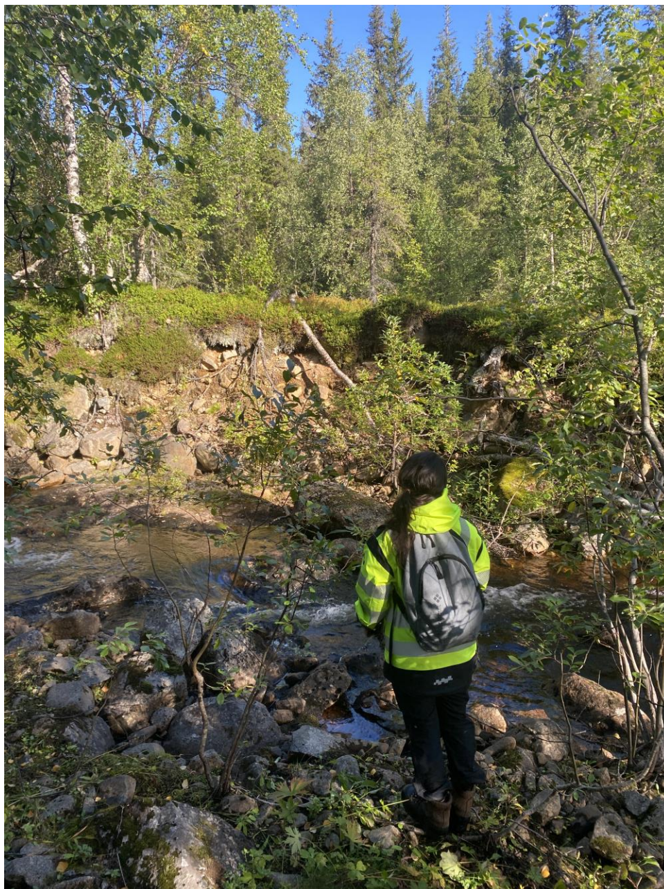
Figur 13. Mindre skredärr/erosionssläpp vid Dunderbäcken. Ärret är omkring 6 x 3 meter i plan och bakkanten är ca 2,5 meter hög. IMG_7292.jpg.
