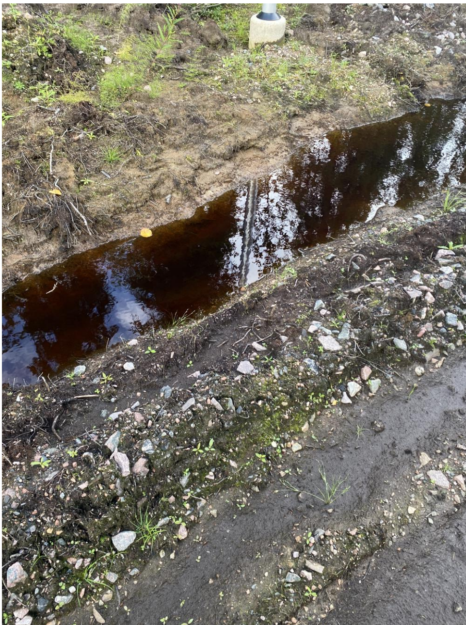
Figur 3. Dike invid väg. Vattenyta omkring 0,7 meter under omgivande mark. IMG_7129.jpg.
