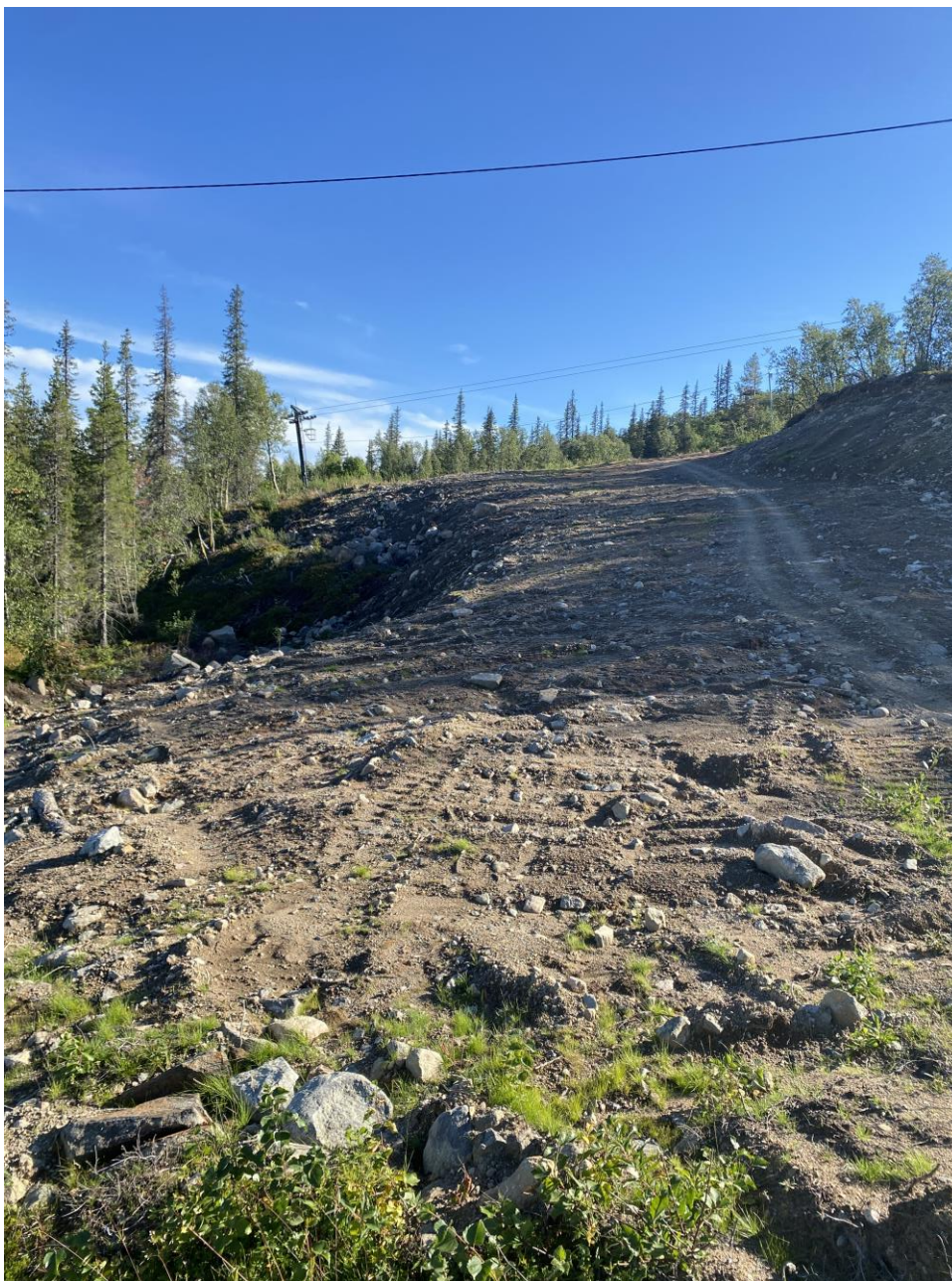
Figur 32. Släntgeometri ändrad genom uppfyllnad. IMG_7432.jpg.
