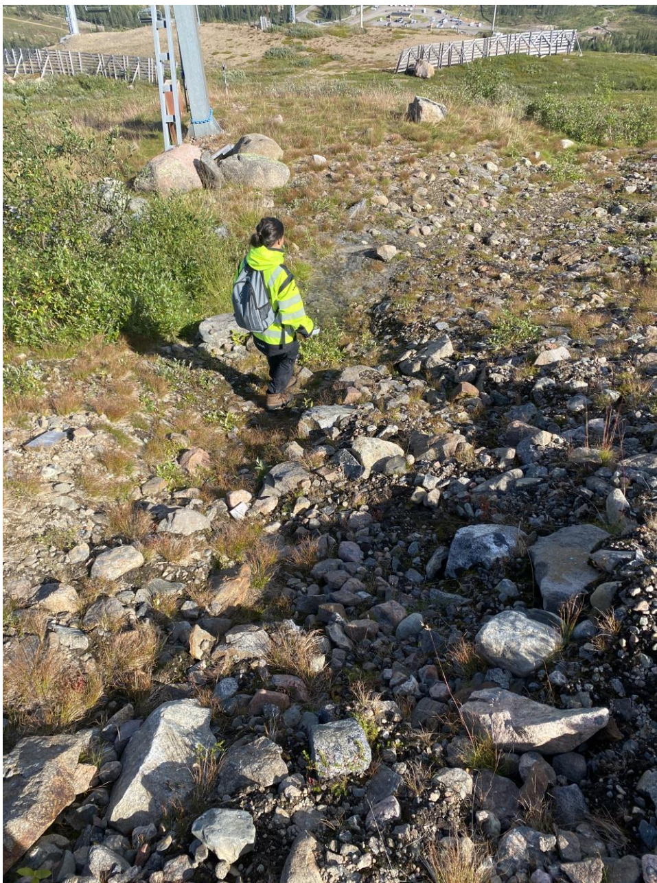
Figur 25. Blottad jord och tecken på viss erosion av finmaterial. IMG_7363.jpg.
