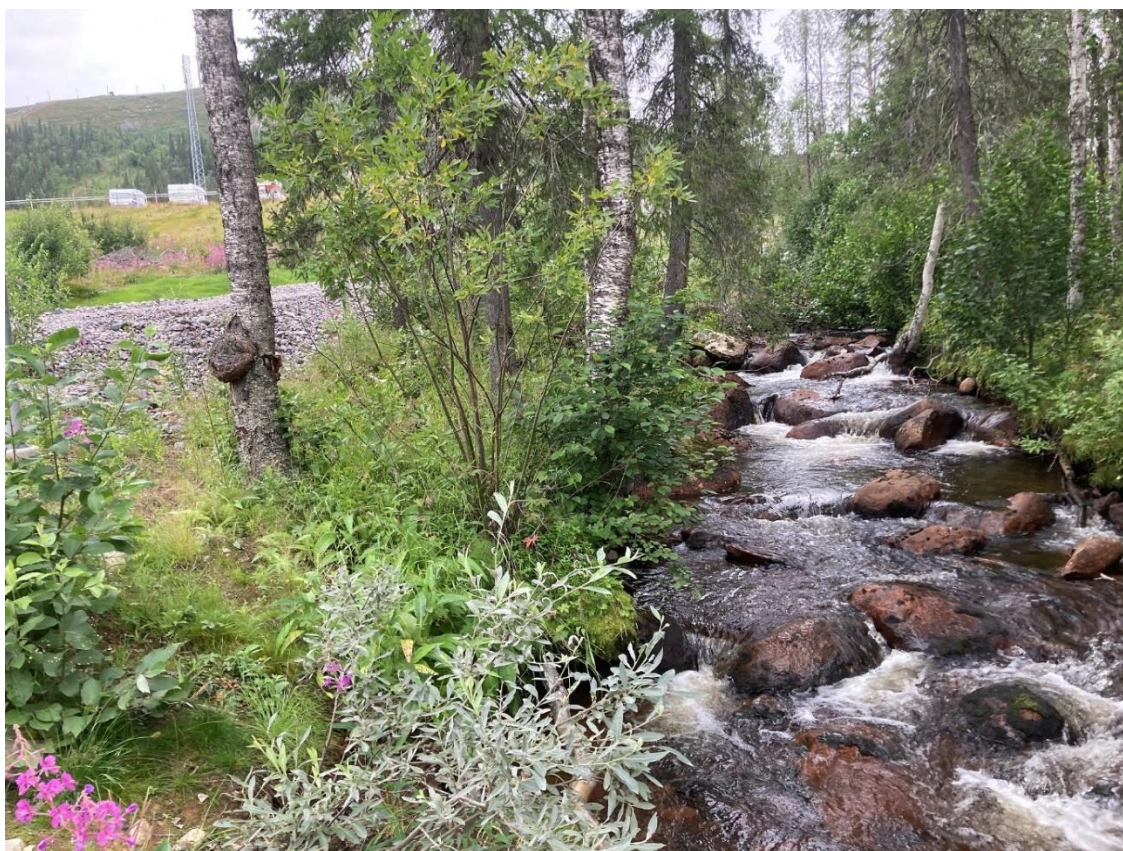
Figur 18. Delsträcka 5. Blockrik strömsträcka där vegetation har tagits ner för vägbyggnation till vänster i bilden.
