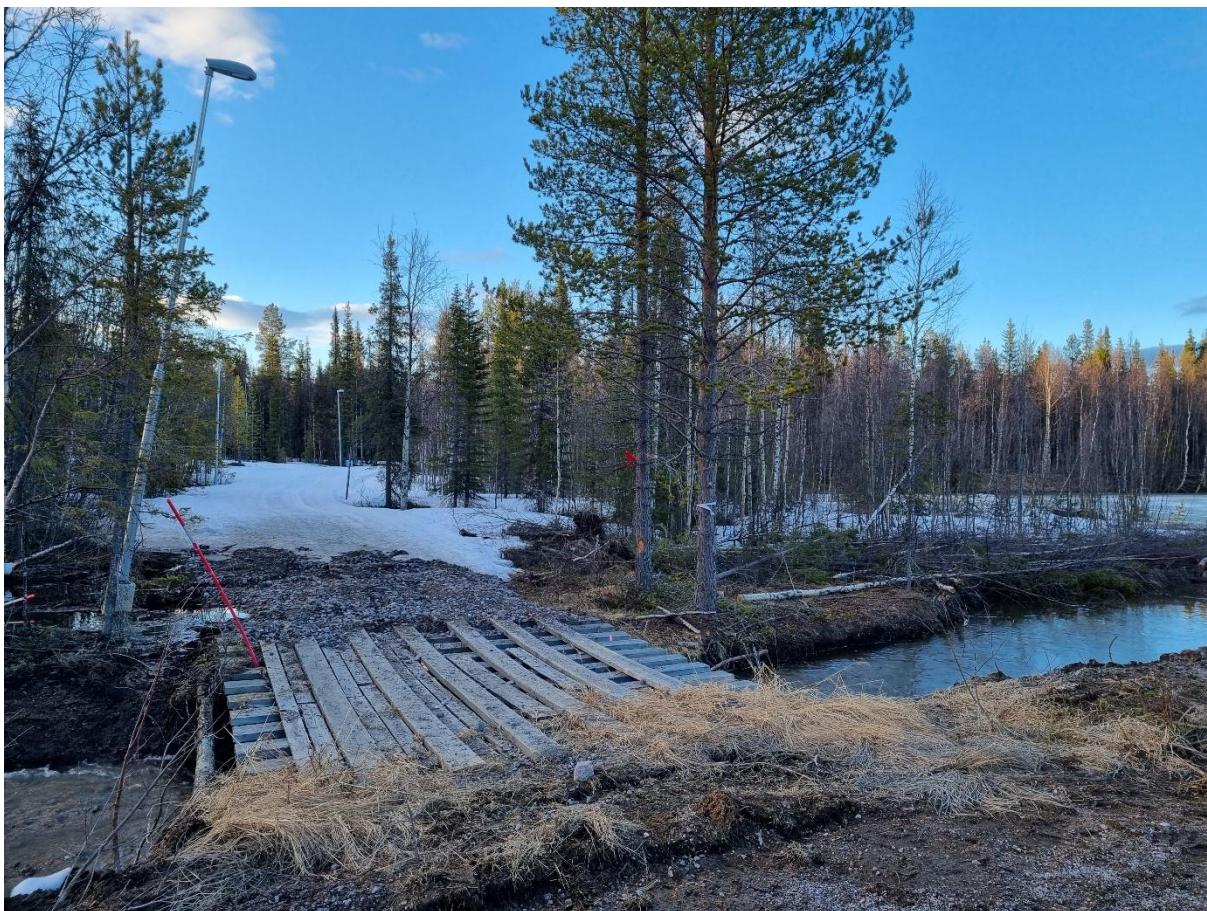
Figur 47. Befintlig överfart för skoterförare, cyklister och gående över Dunderbäcken.
