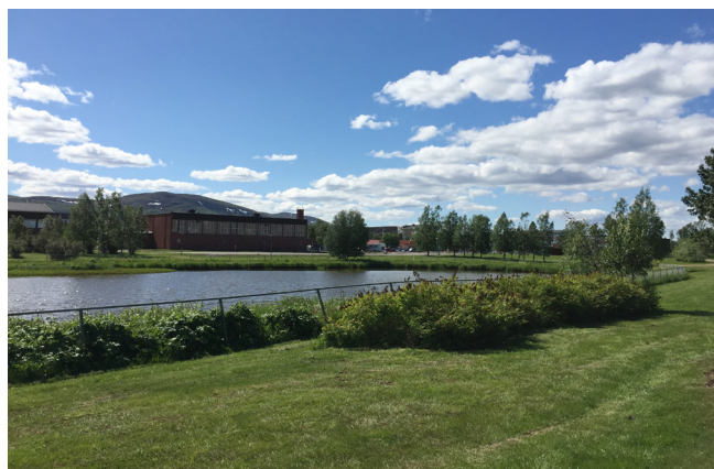
Sjöparken kommer att byggas om och förbättras.
