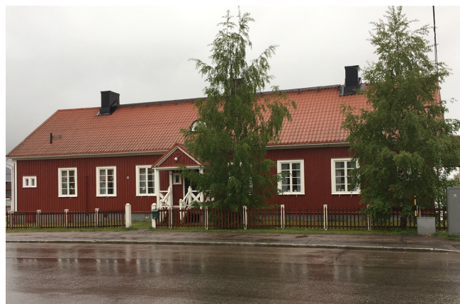
Byggnad inom Vassara 10 som föreslås bevaras.
