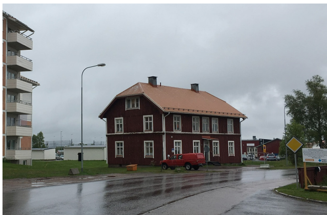
Den gamla SJ-byggnaden ska bevaras.
