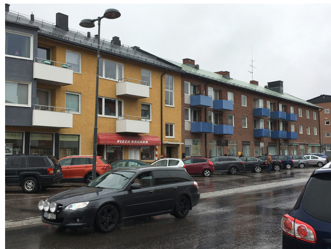
Malmbergsvägen är ett exempel på ett stråk med bostäder med lokaler i bottenvåningen.
