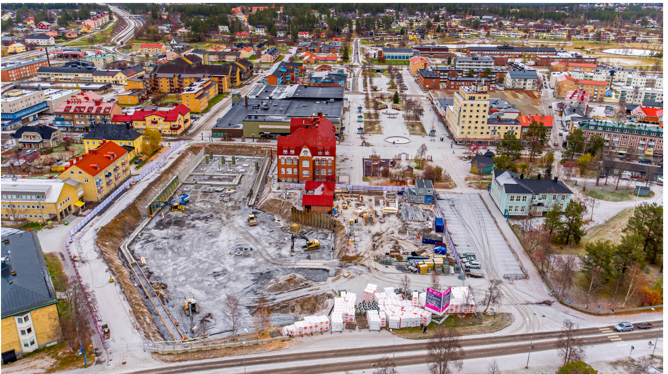
Under byggskedet av Kunskapshuset. Parken som tidigare fanns söder om torget syns närmast i bild och utgör en del av byggarbetsplatsen. Foto: Daniel Olausson.
