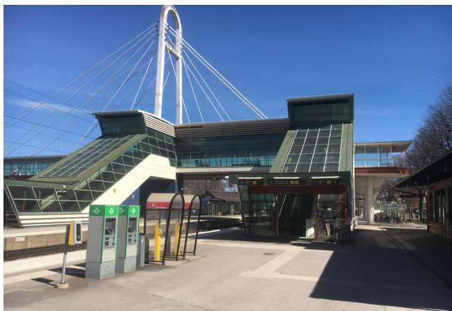
Exempel på passage över järnvägsspår för fotgängare och cyklister som tillgodoser krav på tillgänglighet i Hallsberg.
