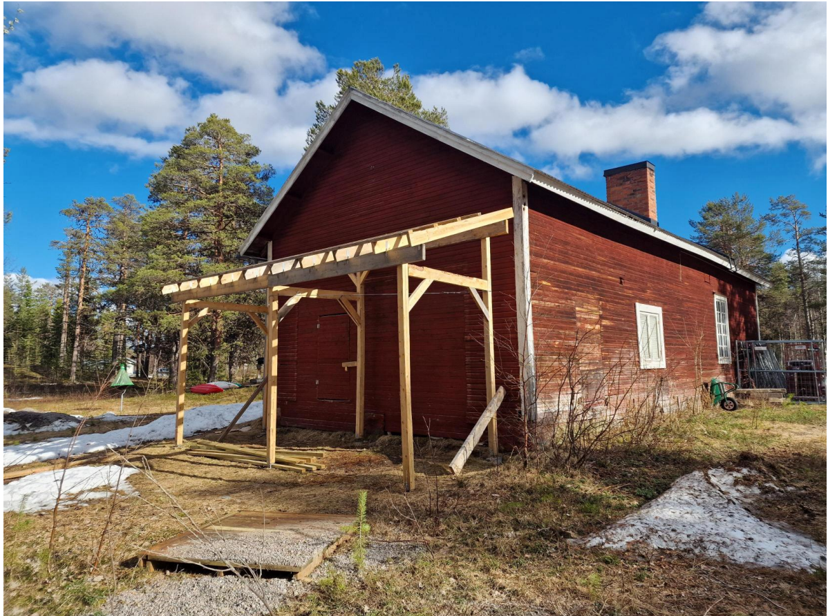
Komplementbyggnaderna i den nordvästra delen av fastigheten.
