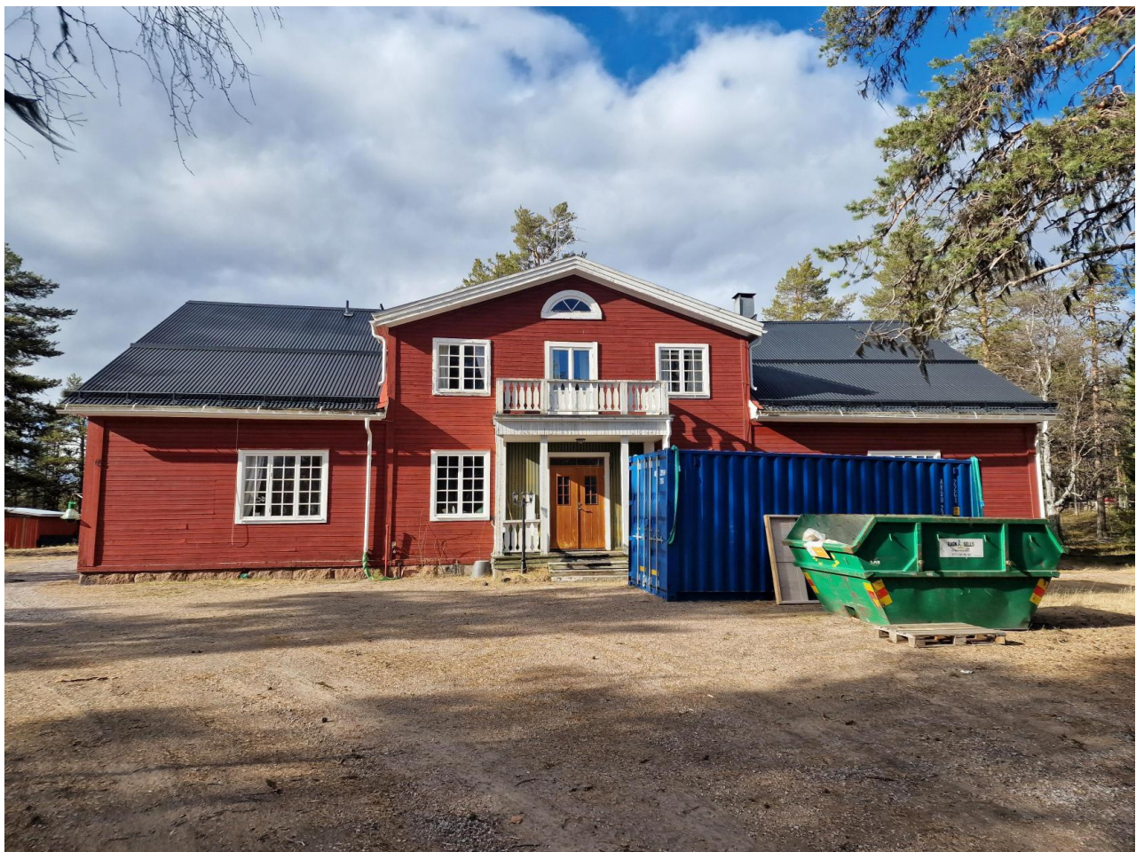
Befintlig huvudbyggnad, det före detta församlingshemmet.
