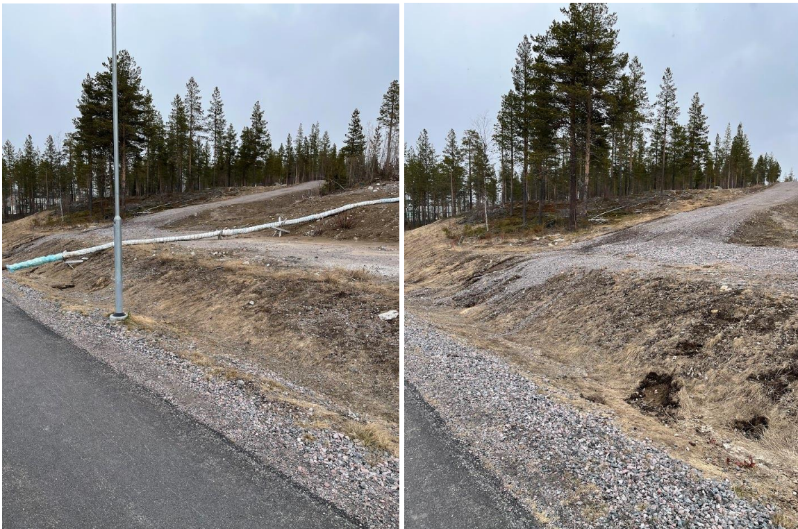
Foton över planområdet taget från GC-väg längst Dundretvägen. Byggväg syns närmast i bild (Foton AFRY 2022-05-17).
