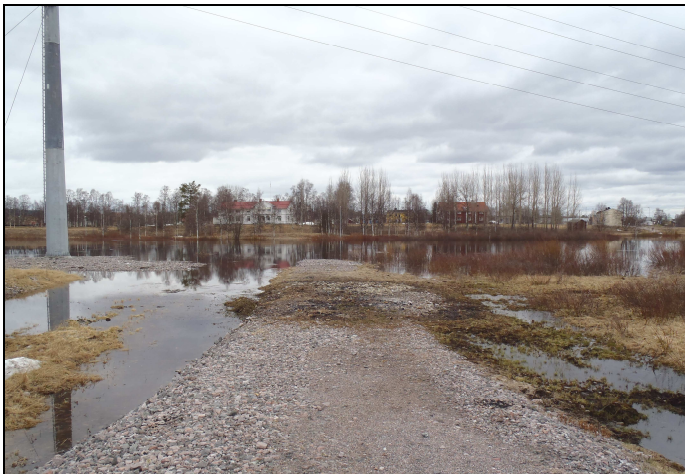
Befintlig pir av makadam ut till kraftledningsfundament i älven. Vy mot norr.
