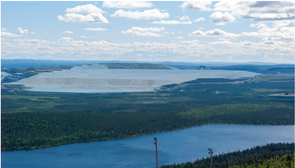
Figur 30. Fotomontage över Aitik med vy från Dundret. Montaget visar möjlig utökning av gråbergssupplag enligt planförslaget, samt planerade dammhöjningar till och med år 2046.
