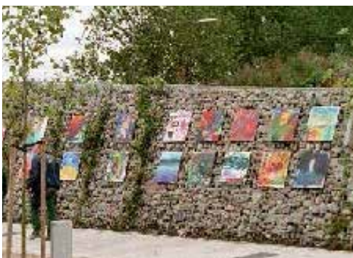
Exempel på stödmurar av natursten och stål nät
